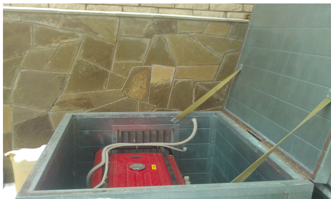
Ремонт и обслуживание бензогенератора ELEMAX
